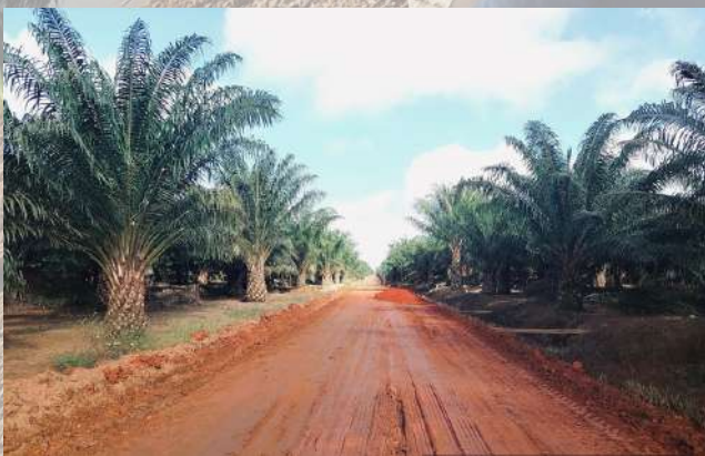
Bantuan PT. IJS dalam Membangun Infrastruktur Jalan PT IJS Assistance in Building Road Infrastructure
